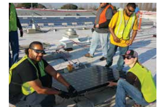
Il lavoro di squadra sui tetti
